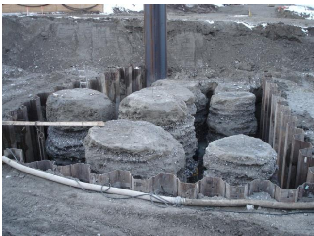
Abb. 2: Steiner Thomas: Freigelegte DSV-Säulen
